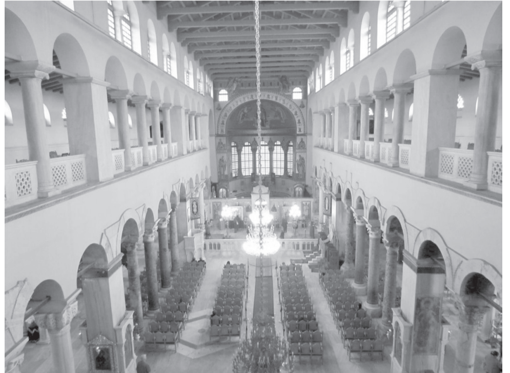
Interiorul bisericii Sf. Dimitrie din Salonic. Se pot observa și stâlpii mai vechi de la fostul templu antic, strânși în cercuri de oțel
